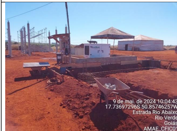
Autor: AMAE Foto: Base do gerador de energia, e gerador em funcionamento.
