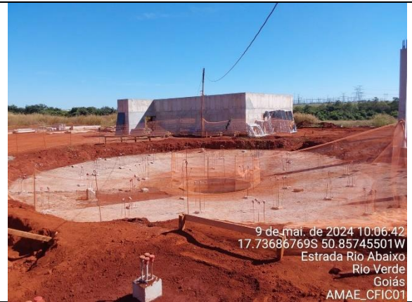
Autor: AMAE Foto: Início das obras do Decantador Terciário da ETE Laje.
